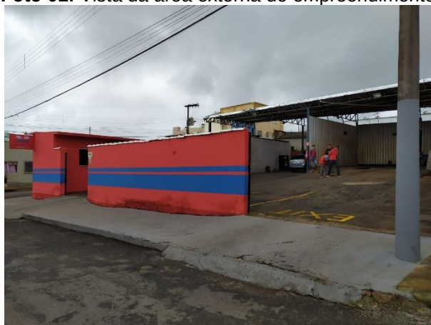
Foto 01: Vista da área externa do empreendimento.
