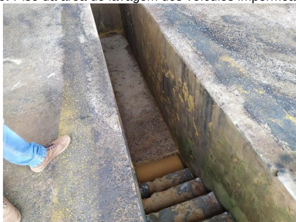
Foto 06: Piso da área de lavagem dos veículos impermeabilizado.
